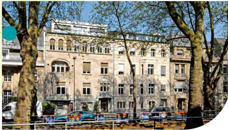
Erst seit der umfangreichen Sanierung der Fassade von Haus 38 im Jahr 2008 bietet die Häuserreihe in der Lindemannstraße 34-42 ein geschlossenes Bild.
