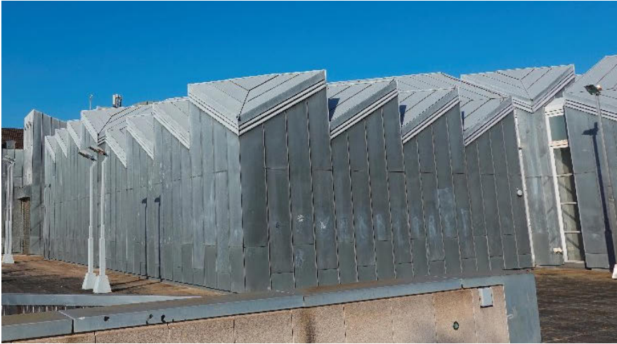
Moderne Architektur: „Der Architekt schafft ein autonomes Kunstwerk – für Kunstwerke und Menschen“, so Hans Hollein über die Planung des Museums Abteiberg. Das markante Sägezahn-dach schafft Platz für viele Fenster und die Kunstwerke im Inneren erstrahlen in natürlichem Licht.
