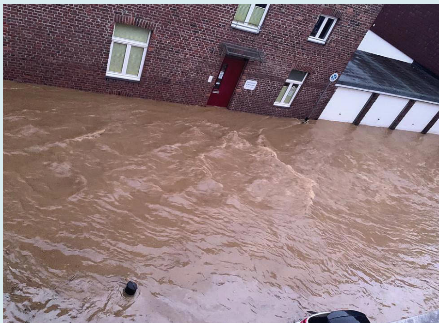
Am Morgen des 15. Juli stand das Wasser jedoch bereits so hoch, dass das Erdgeschoss des Hauses und damit die Praxis von Andrea Heinrichs überflutet wurde.
